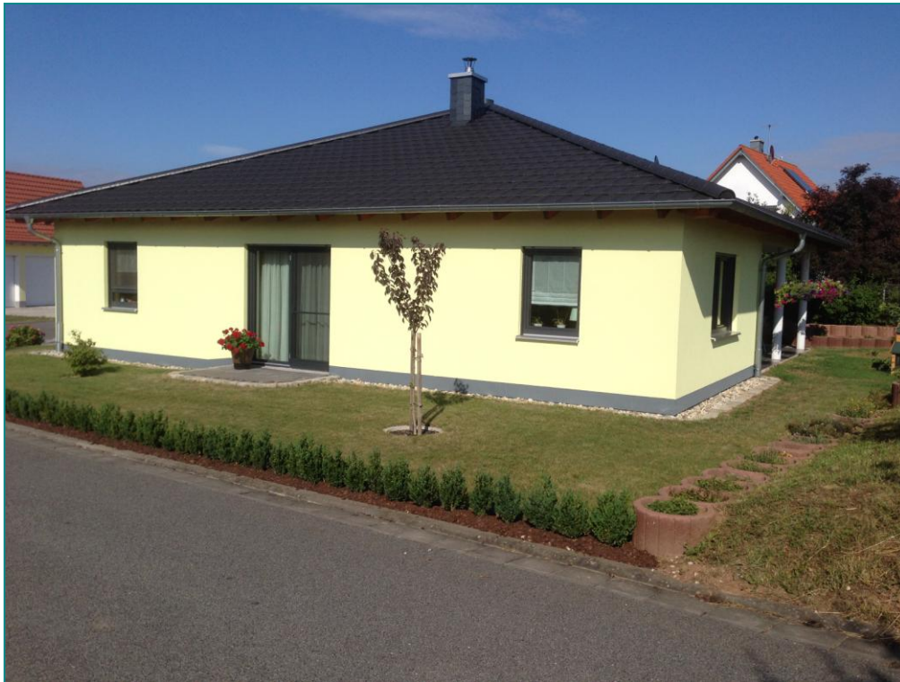
Haus Mandy, schlüsselfertig mit Sonderausstattung
